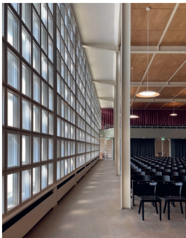
Die Stahlskelettkonstruktion hinter der grossen Glaswand im Kirchenraum
