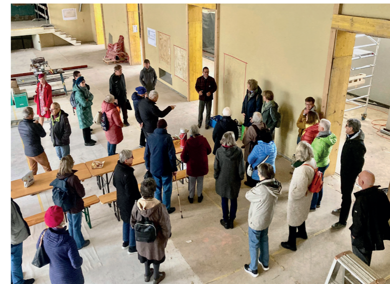
Führung durchs Zentrum Johannes im Herbst 2023: Interessierte Zuhörerschaft bei einer Baustellenführung
